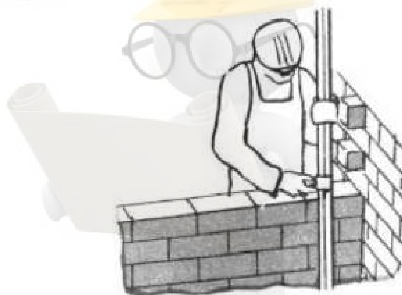
Рис. 9 - Натягивание причального шнура
