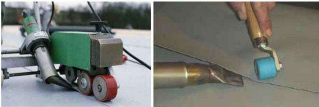
рис. 9 Автоматическая и ручная сварка мембран
